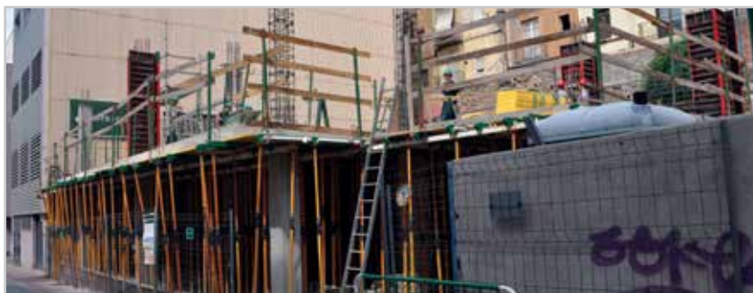
En aquest primer tram de feina s'ha aixecat el sostre que correspon a la planta soterrani 2
