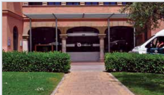
La porta d'accés a l'Hospital de dia s'ha renovat
