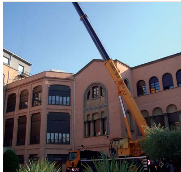
Col·locació de l'equip de climatització
